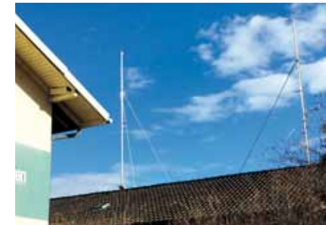
Die Profile zeigen an, wo dereinst der Energieholzlagerplatz in Muttenz entstehen soll.
