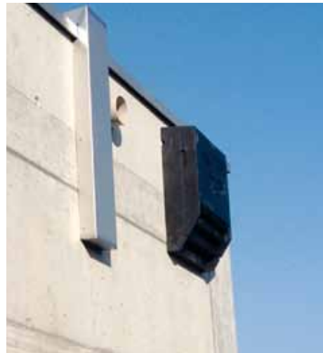
Fledermauskasten an der Fassade
