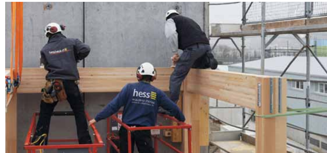
Ein Leuchtturmprojekt entsteht...
