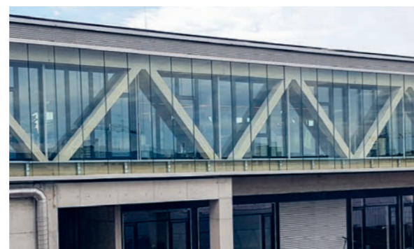
Büroaufstockung der Holzwerkstoffwerk Basel AG mit Fachwerkträgern aus Fagus-Stabbuche, die eine statische Länge von 35 Metern überbrücken.
